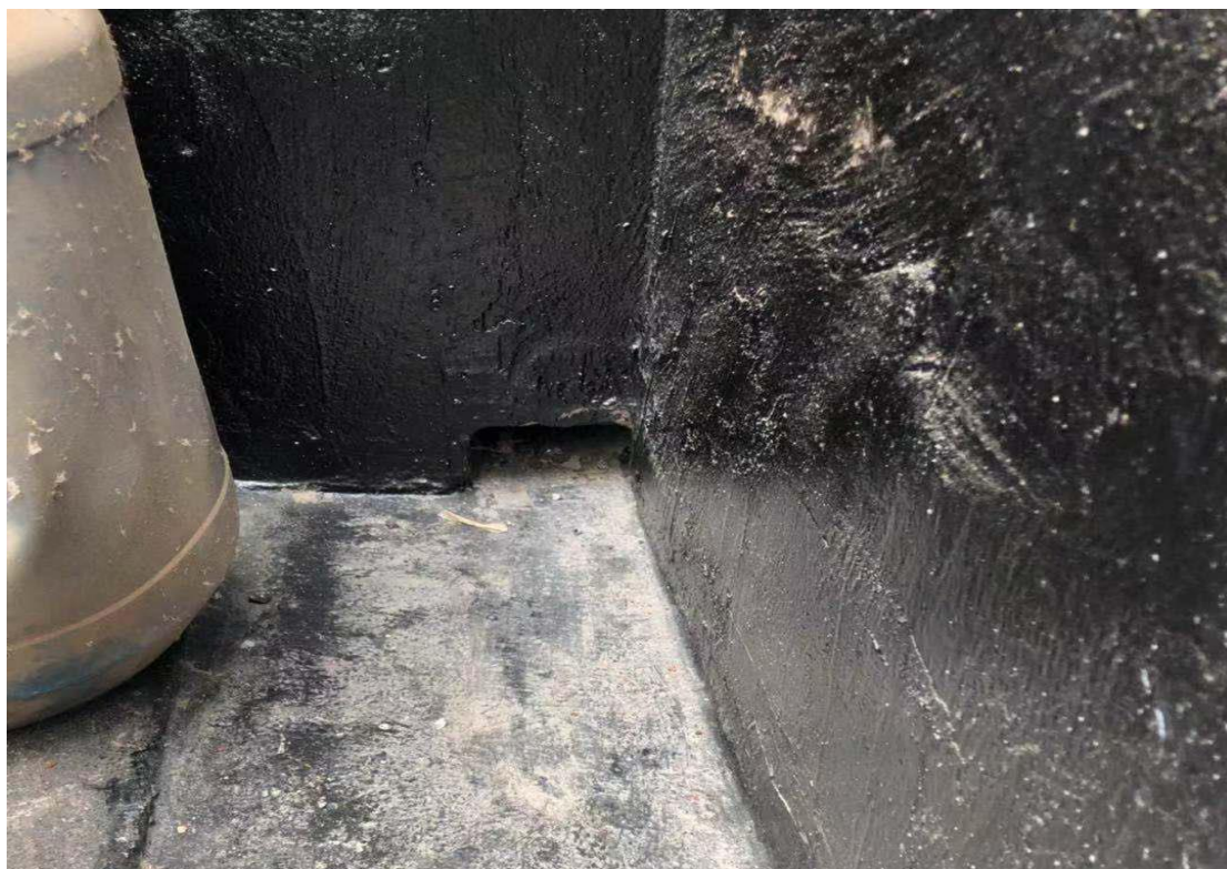
图 8.2-5 定型废油堆放场所
